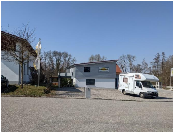
Abb.2 Ostansicht Blumthaler Straße 2a
