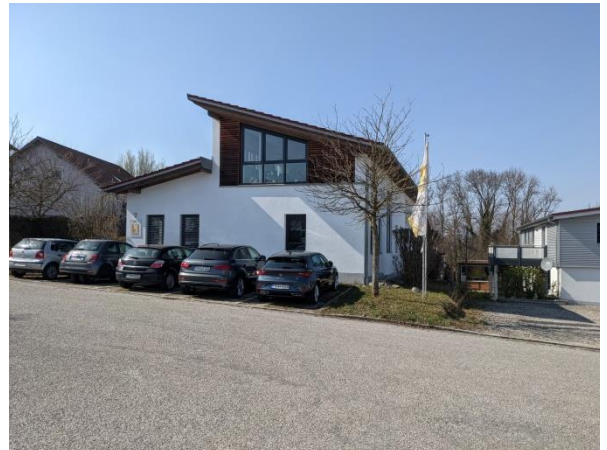
Abb.3 Ostansicht Blumthaler Straße 4
